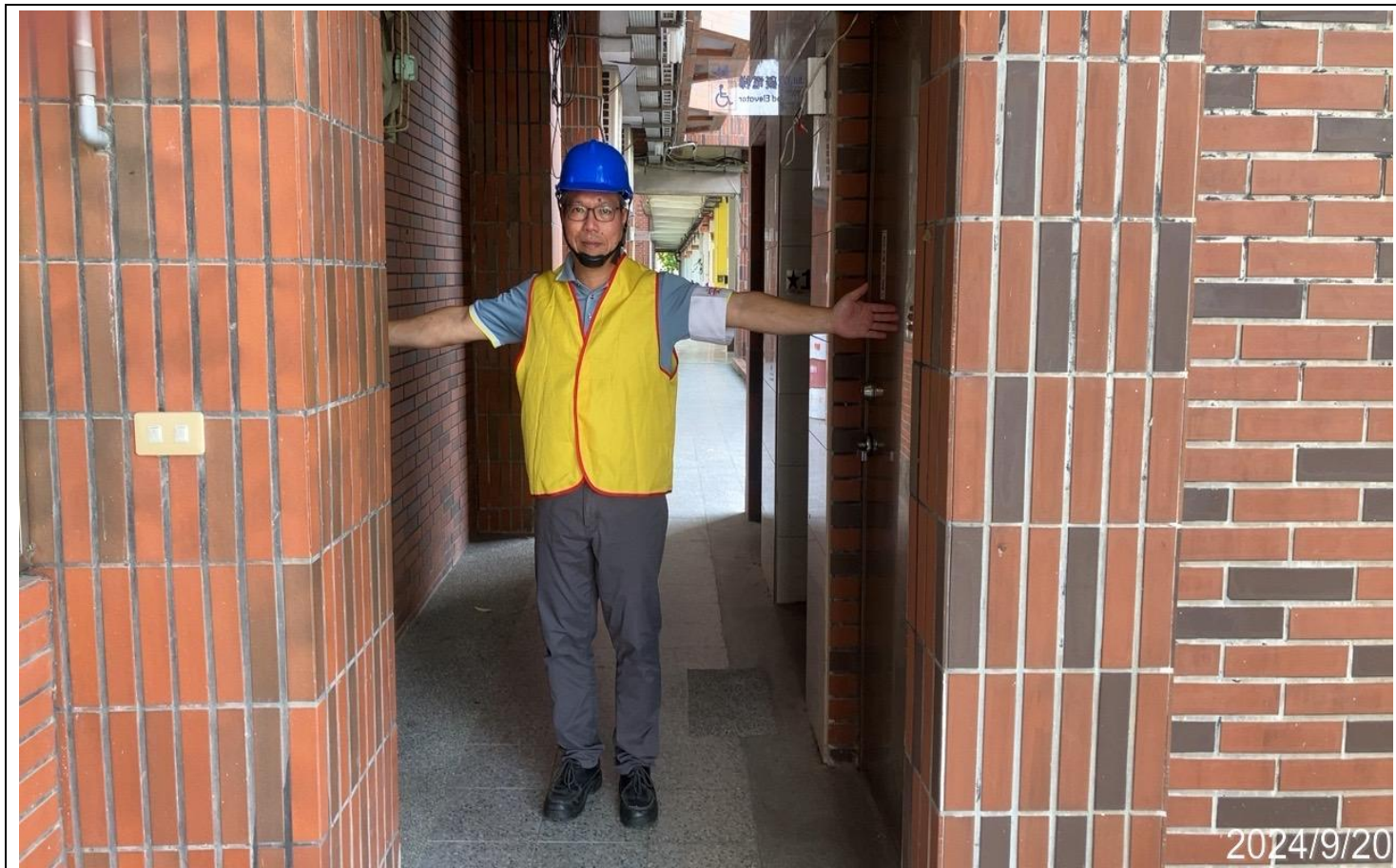
內容說明：避難期間禁止人員搭乘電梯(安全防護班訓練)
